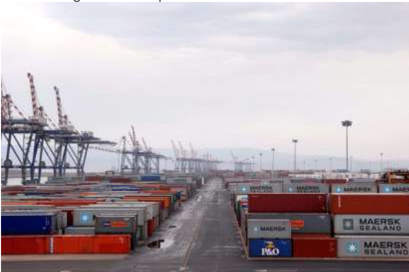
GIOIA TAURO PORTO GRANDI INFRASTRUTTURE HUB CONTAINER GRU
